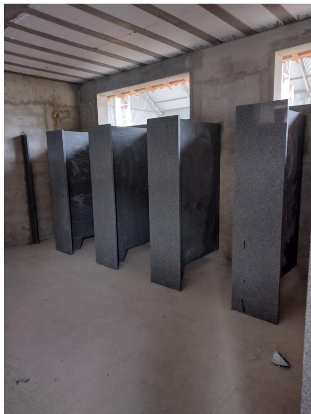
INSTALAÇÃO DAS DIVISÓRIAS DE GRANITO NOS SANITÁRIOS.
